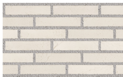
Tegel på huset närmast vattentornet Ljus tegel med mörkare fog
