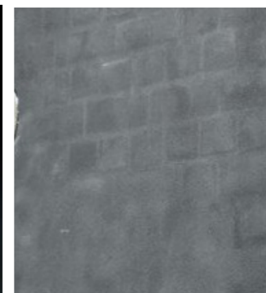
Puts gråskala med detaljering i näraliggande kulörer
