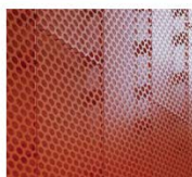
Fönsterbröstningsdetaljer i perforerad plåt
