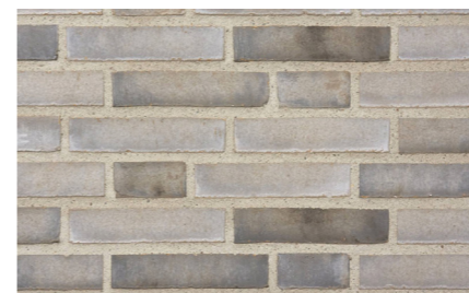
Tegel på huset närmast paviljongen Blandade tegel i gråa nyanser med ljus fog
