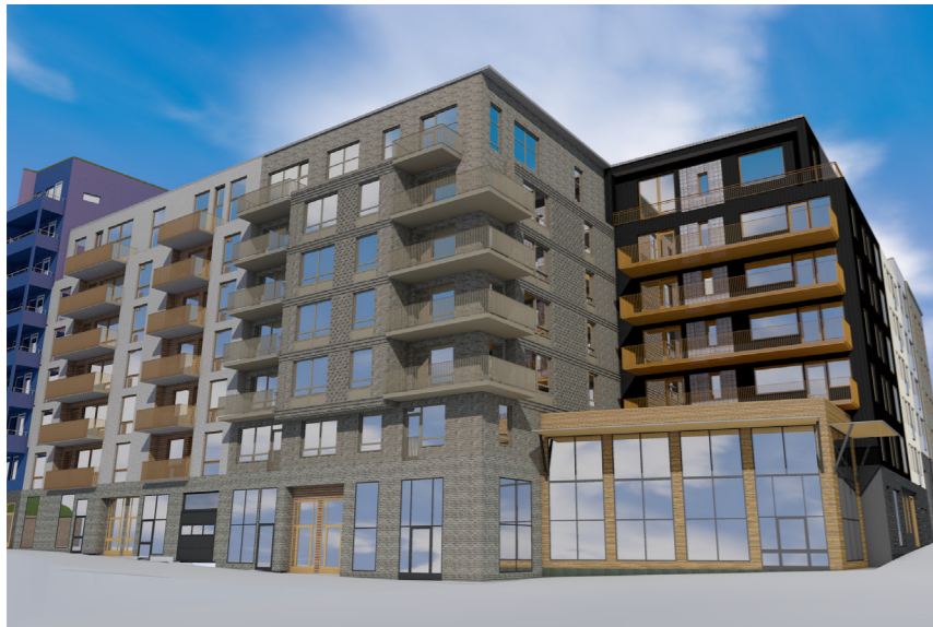
Vy från tunnelbanastations entré
