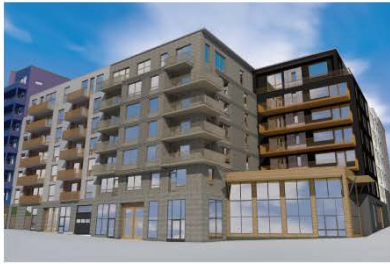
Vy från tunnelbanastations entré
