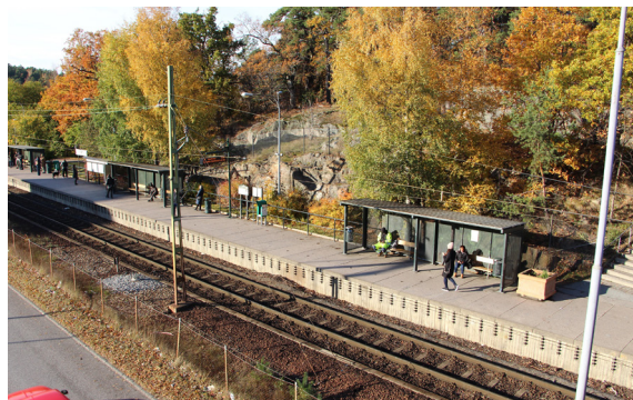
Perrongen är enkelsidig och ligger idag norr om Saltsjöbanan.
