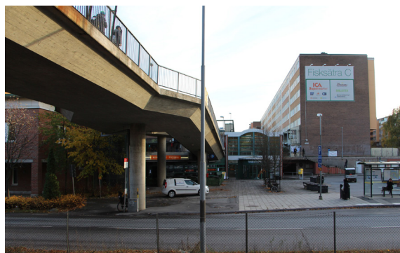
Gångbro över spåren och entré till centrumanläggning.
