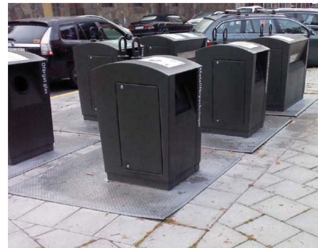
Referensbild, nedgrävda behållare för avfall
