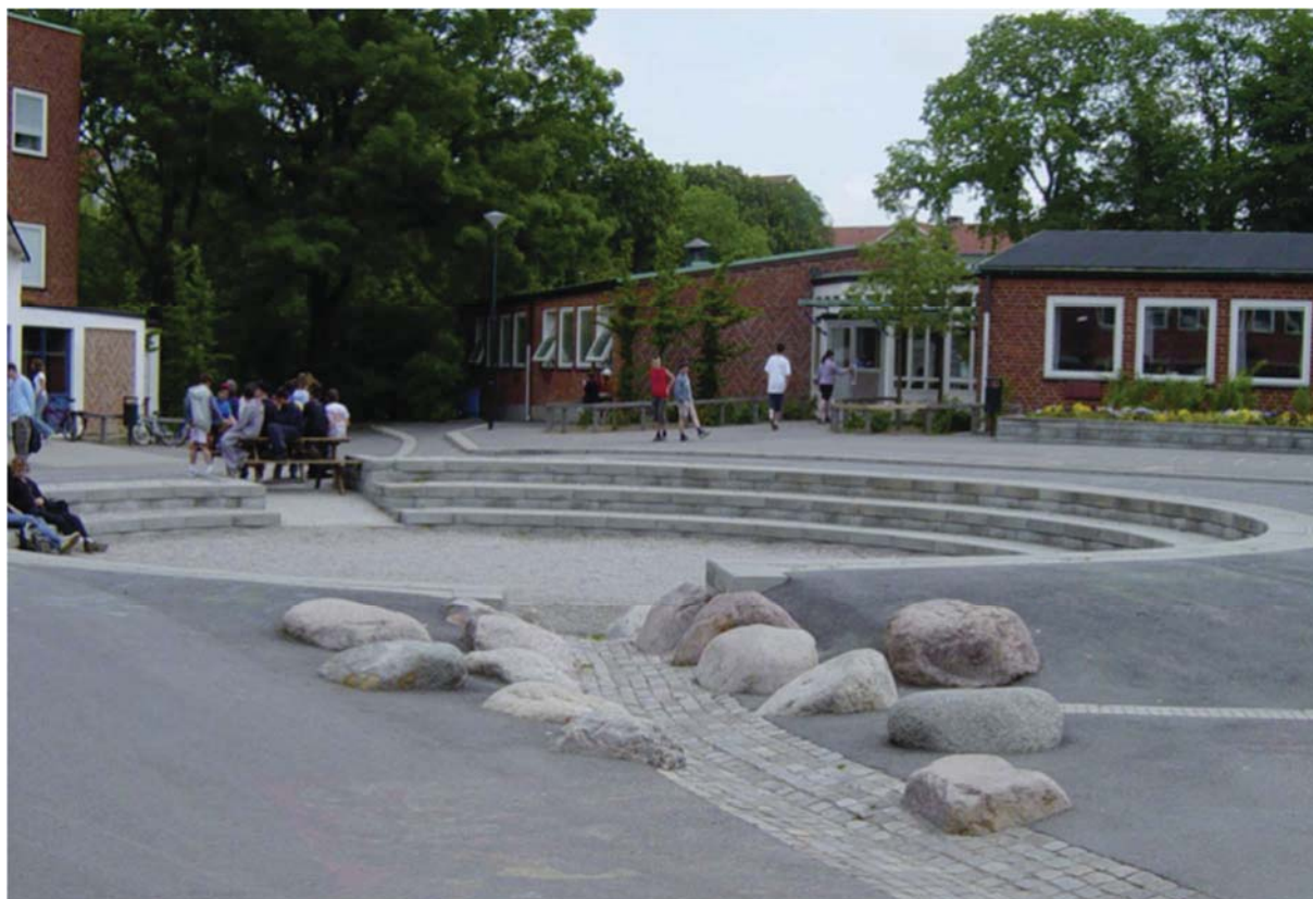
Figur 9. Exempelbild på en kontrollerad översvämningsyta från Augustenborg i Malmö.
