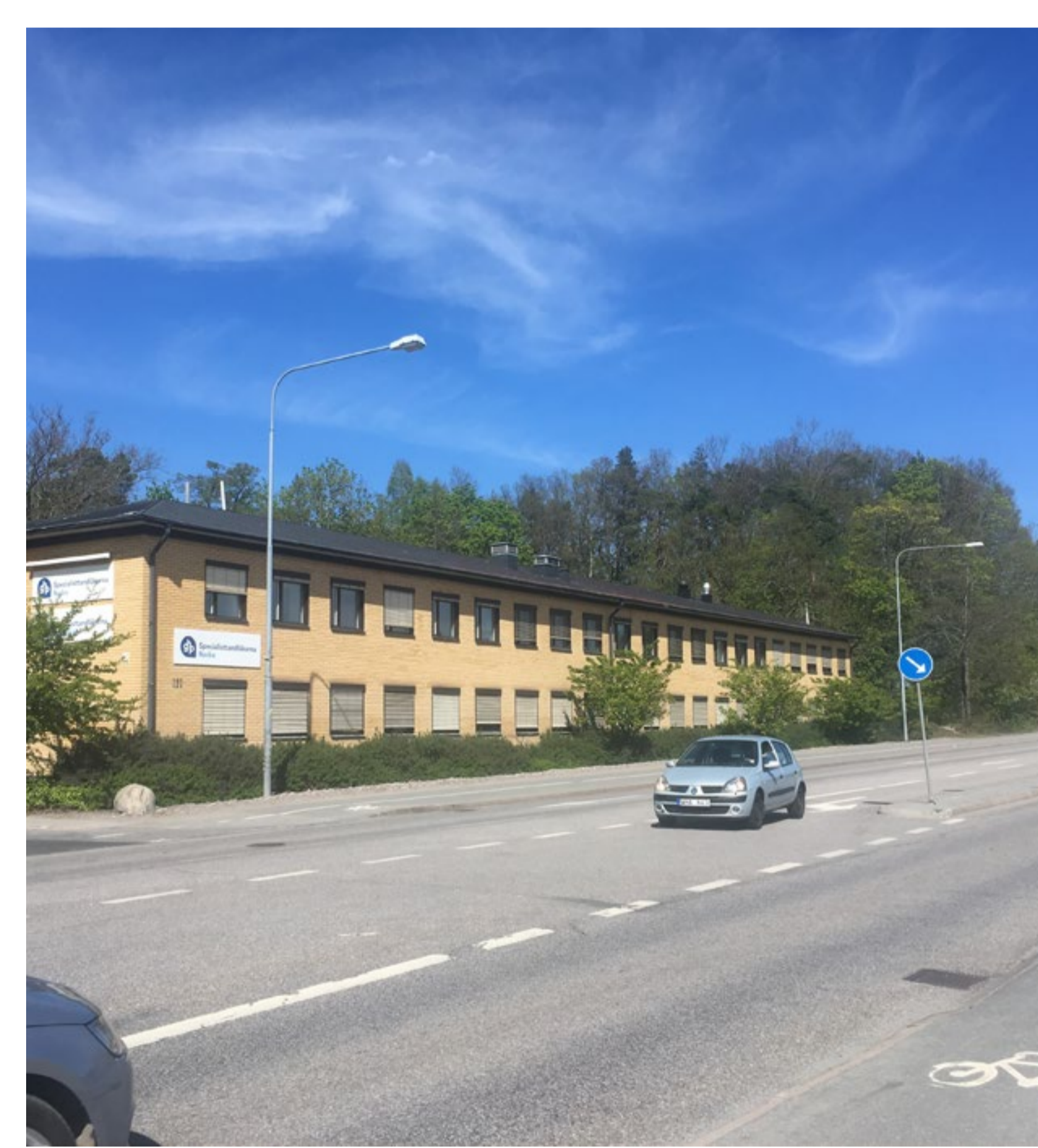
Kontorsbyggnad mot Värmdövägen
