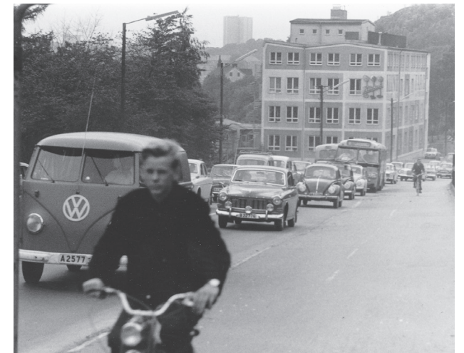
Klintens färgfabrik i direkt anslutning till den trafikerade Värmdövägen år 1965. Fotograf okänd. Nacka lokalhistoriska arkiv.
