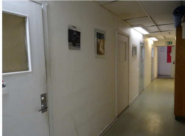
Kontorskorridor med linoleummatta.
