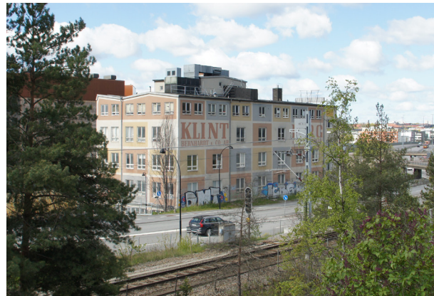
Färgfabriken Klinten sett från andra sidan Värmdövägen.
