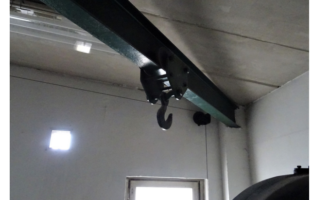
Travers i hissmaskinsrummets tak.
