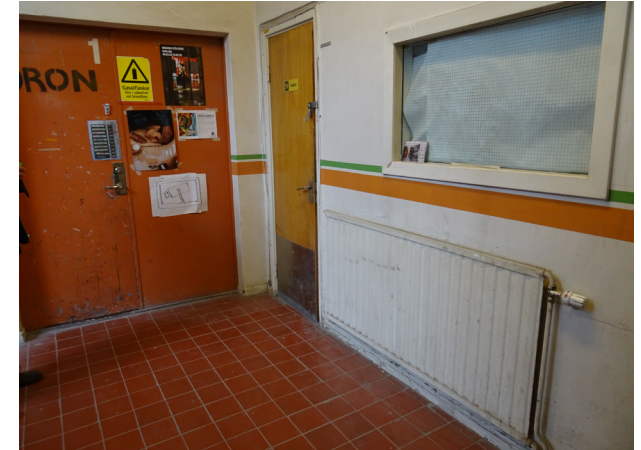
Trapphus med ursprungliga dörrar in till bottenvåningen samt toalett till höger i bild. Glasad öppning i trådglas mot kontorsdel.
