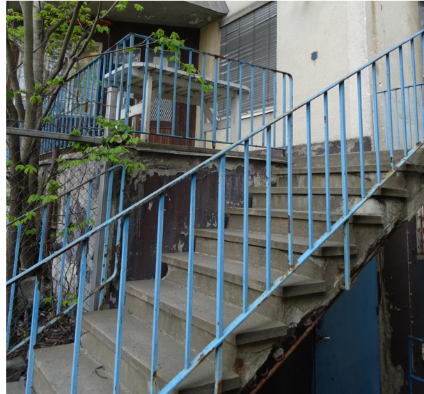
Betongtrappa med ursprungligt smidesräcke leder upp till entrén.
