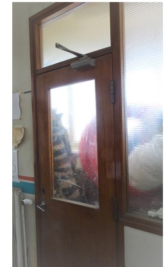
T.v. Dubbeldörrar från vindfång in till trapphus med ursprungligt trycke. T.h. Ursprunglig dörr med glasat parti i trådglas in till vaktmästarbås.
