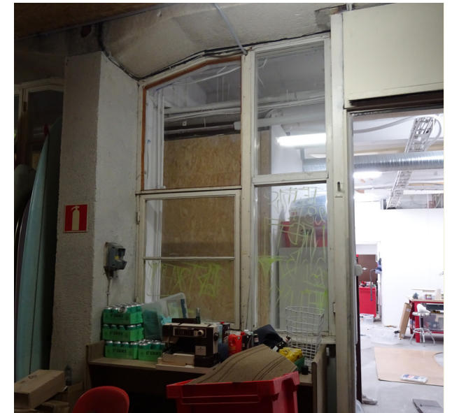
De ursprungliga fönsterpartierna finns bevarade innanför den inbyggda lastkajen. I denna har en dörröppning tagits upp.
