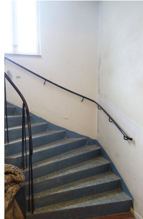
T.v. Trappa med trappsteg målade med flingfärg. Handsmitt, smäckert, svartmålat trappräcke med avlägset placerade räckspelare i tre delar. T.h. Vy från laborativåning och nedåt. Handsmitt, smäckert, svartmålat trappräcke med avlägset placerade räckspelare i tre delar.
