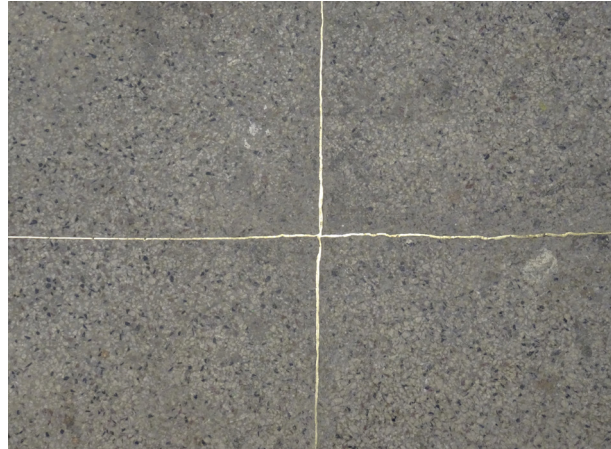
Gjutet betonggol med synlig ballast.
