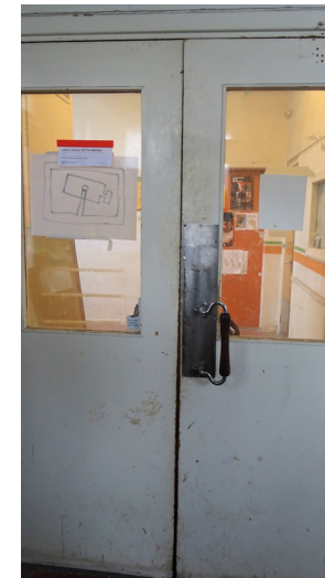
T.v. Dubbeldörrar från vindfång in till trapphus med ursprungligt trycke. T.h. Ursprunglig dörr med glasat parti i trådglas in till vaktmästarbås.
