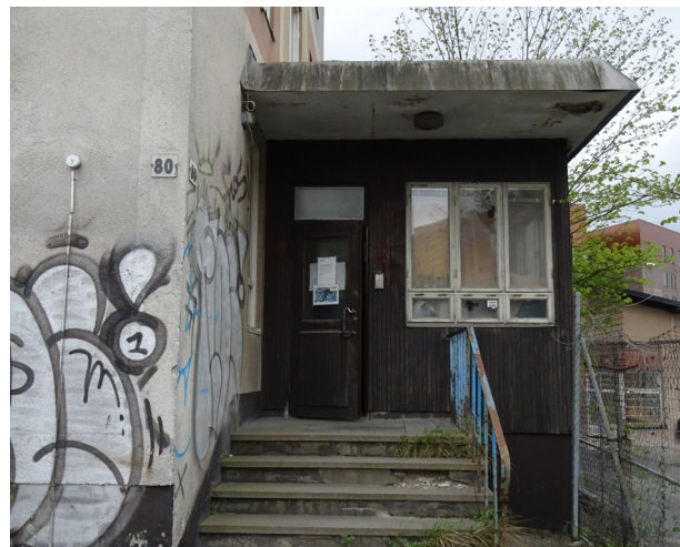
Entréutbyggnad från norr, klädd i mörkbrun karosseripanel.
