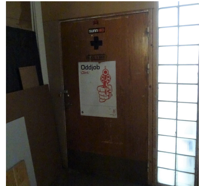
Dörrparti med sidoljus i sekundär vägg.
