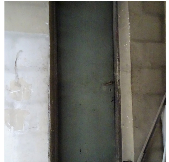
Ursprunglig plåtdörr ut till taket.
