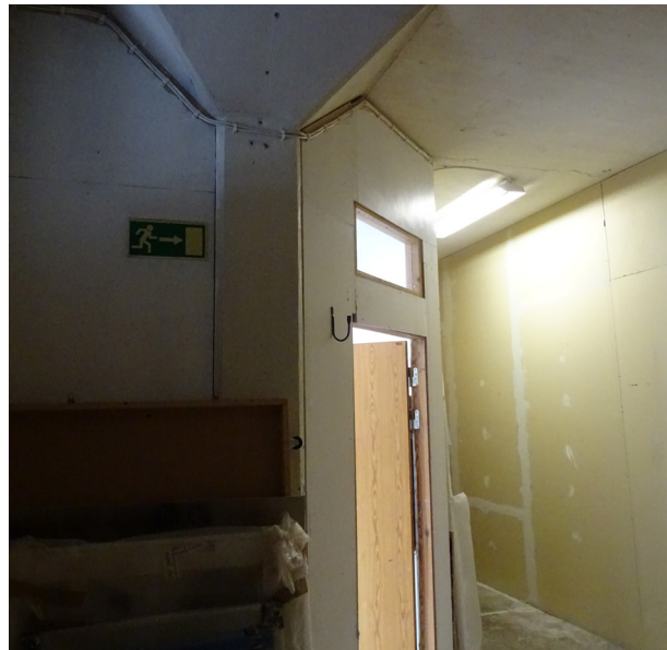
Pelare och brädgjutet tak. Sekundär planlösning med väggar av provisorisk karaktär.
