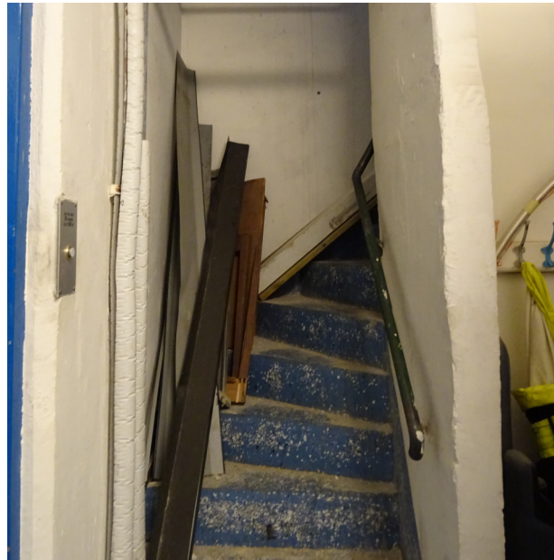
Trappa från laboratorievåning upp till takplan.
