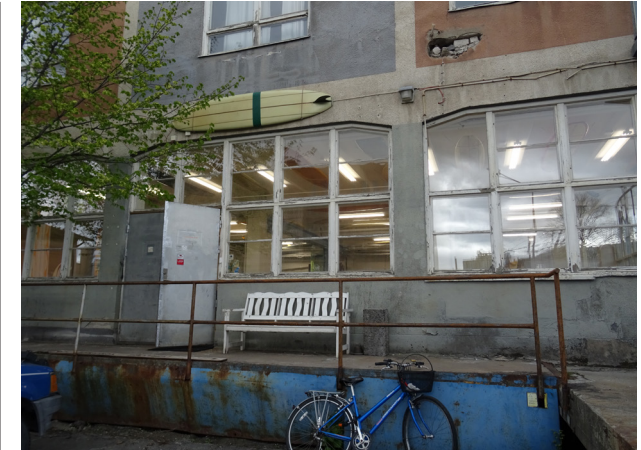
Souterrängvåningens karaktäristiska fönster, ursprunglig dörr, sekundärt plåtinklädd.
