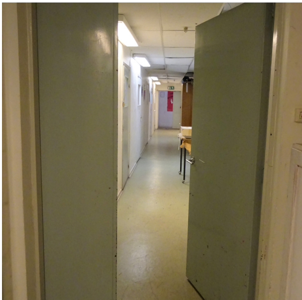
Ursprunglig dubbeldörr i plåt mellan våningsplanets östra och västra del.
