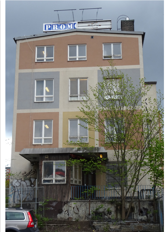
Västgavel. Ursprungligt inbyggt entréparti klädd i stående träpanel. Utskjutande skärmtak.
