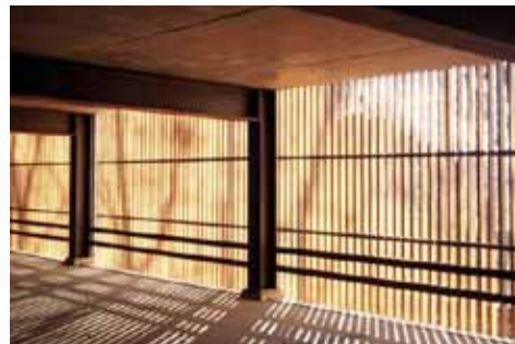
Parking Garage / Birk Heilmeyer und Frenzel Architekten
