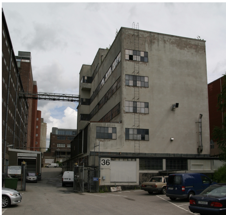
Vy mot öster. Befintligt utseende.
