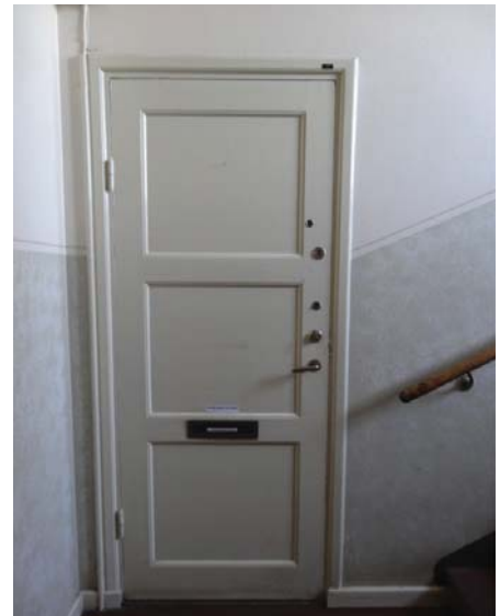
I det äldre lamellhuset hittas denna typ av spegeldörr med tre lika stora speglar som förekom omkring 1930. Dörrtypen finns även i radhusen och bör så långt det är möjligt bevaras. Funktionalismens helsluta dörrblad hade ännu inte kommit i bruk. Dörrfodren har slanka dimensioner. Om lägenhetsdörrar mot trapphus måste bytas ut bör man utgå från befintlig utformning.
