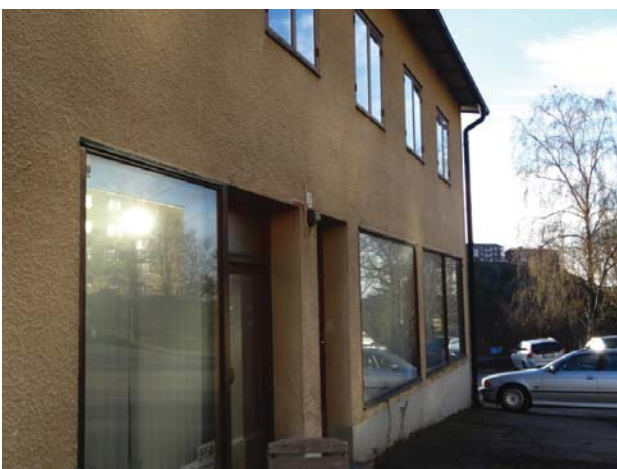
Butiksfönster med bågar av teak. Entrédörrarna är till skillnad från fönstren indragna från fasadliv. Sockeln är putsgrå.
