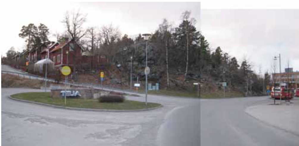
Figur 46. Platsen för tunnelmynningen i Nacka Strand med alternativ C.
