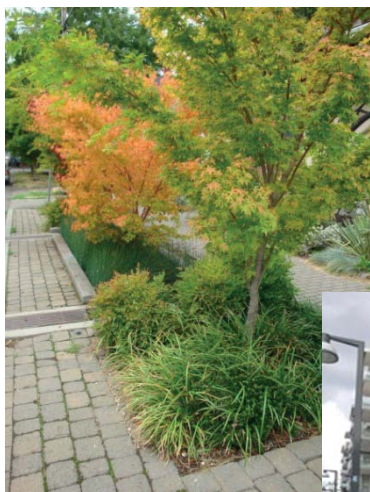
Dagvattenhantering med växtbäddar och regngårdar, Sweco, dagvattengruppen
