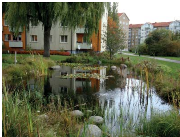
Dagvattenhantering med dagvattendamm, Sweco, dagvattengruppen
