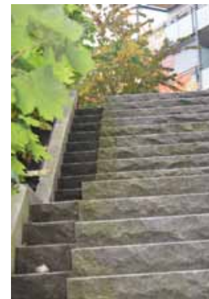
Exempel på dagvattenränna integrerat med trappa
