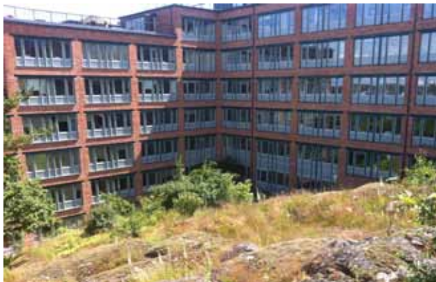
Befintlig byggnad från sjösidan
