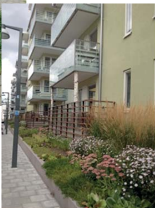
Dagvattenhantering med växtbäddar och regngårdar, Sweco, dagvattengruppen
