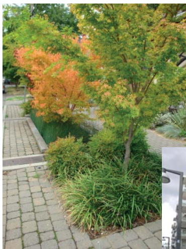
Dagvattenhantering med växtbäddar och regngårdar, Sweco, dagvattengruppen
