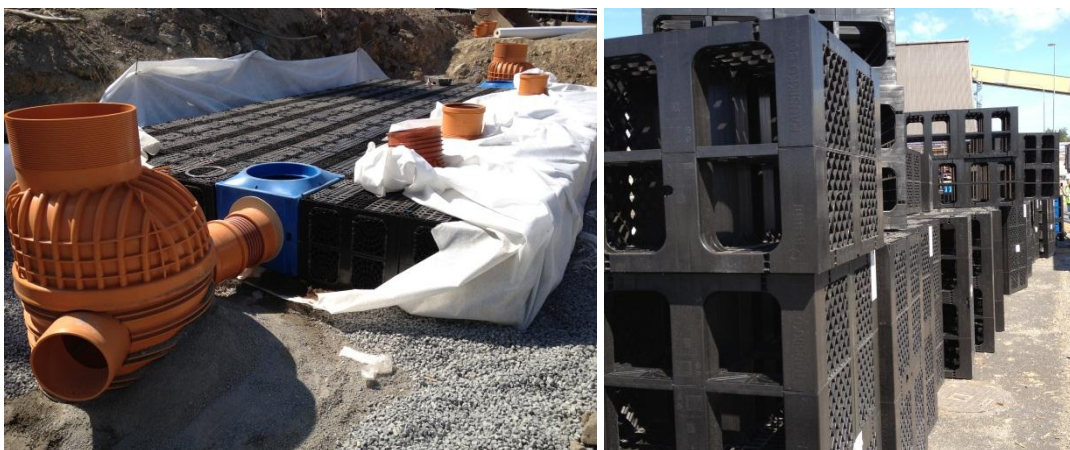
Figur 20. Exempel på dagvattenkassetter i Stockholm.
