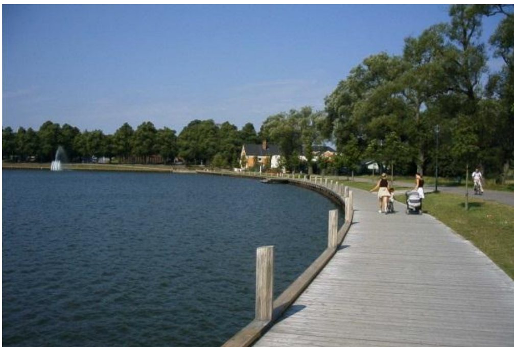
Figur 23. Exempel på utformning av sjöförlagda dagvattenanläggningar med bryggor. I nedre bilden visas en spontad anläggning under promenadstråk i Stockholm och Växjö.
