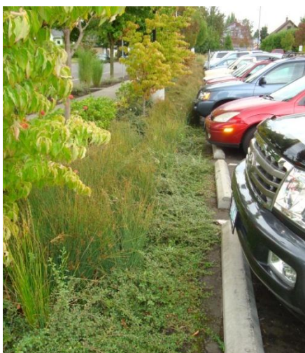
Figur 12. Exempel på utformning av svackdiken längs gata och parkeringsyta, med olika typer av kantsten och utan kantsten. Bilden nedan th är tagen på Sockenvägen i Stockholm, övriga är tagna i Portland, USA.
