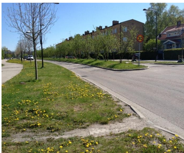
Figur 12. Exempel på utformning av svackdiken längs gata och parkeringsyta, med olika typer av kantsten och utan kantsten. Bilden nedan th är tagen på Sockenvägen i Stockholm, övriga är tagna i Portland, USA.
