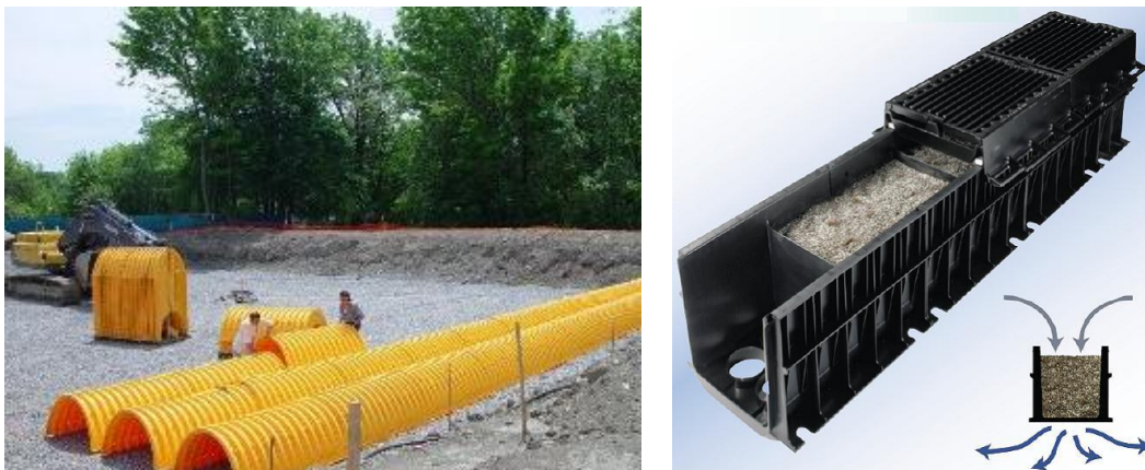
Figur 21 Exempel på lösningen StormTech (th) och D-Rainclean. 3
