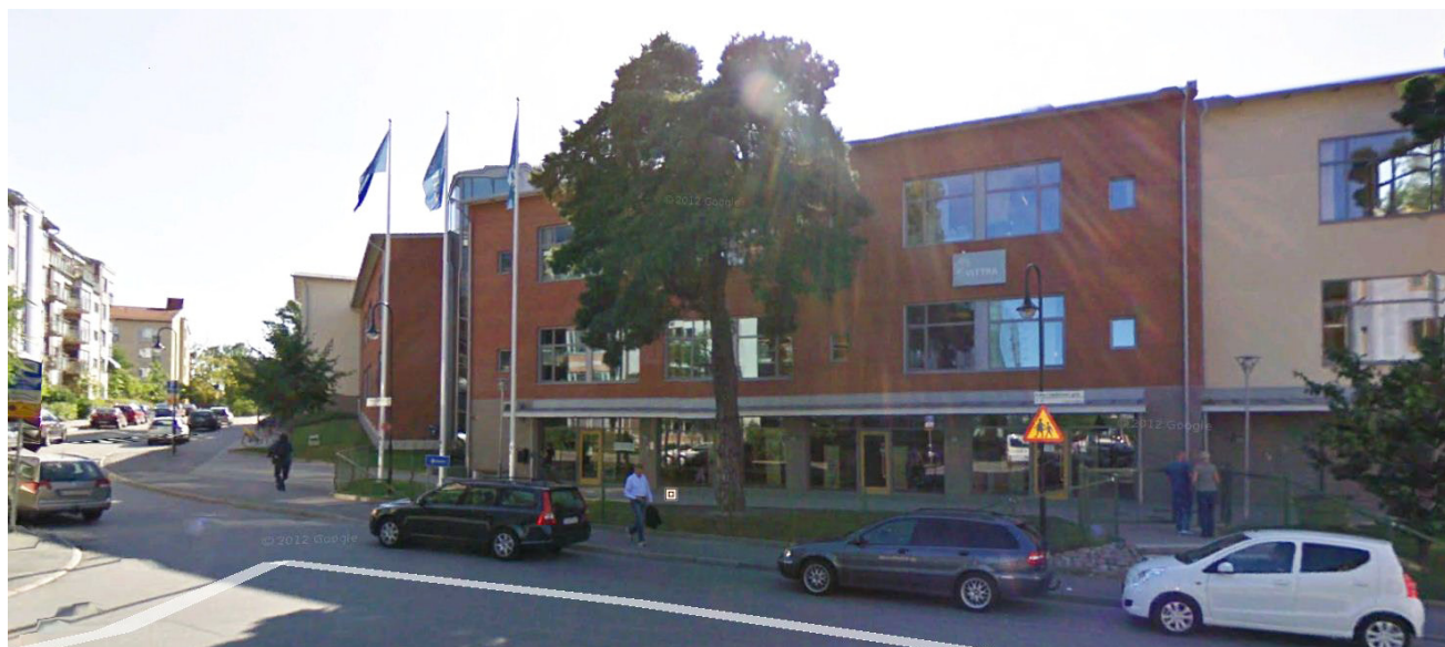
Referensexempel: Vittra Frösunda, förskola och skola. Byggnaden är placerad i liv med gatan och är uppförd i tre våningar.
