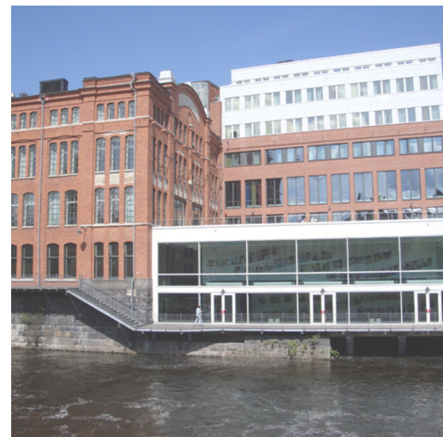
Exempel från industrilandskapet i Norrköping där det framgår tydligt vad som är nytt och vad som är gammalt
