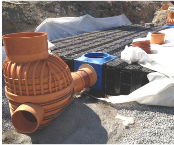
Exempel på dagvattenkassetter i Stockholm Exempel på strandpromenad med dagvattenrening i Liljeholmen. (Bildkälla: Sweco)
