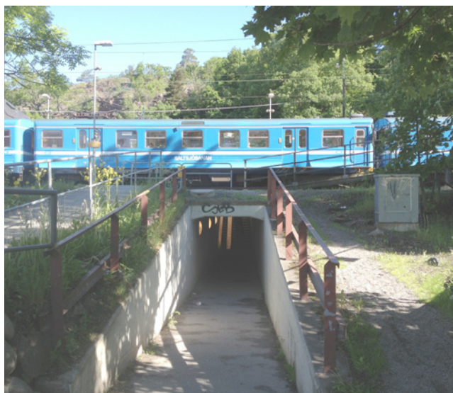
Tunnelundergången under Saltsjöbanan idag
