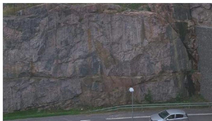
Referensbild. Bergskärning vid trafikplats Kvarnholmen.
