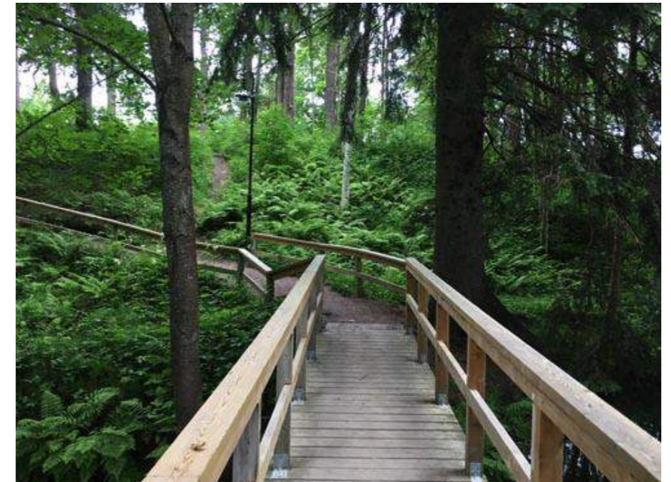
Träkonstruktion för att ta upp höjdskillnad
