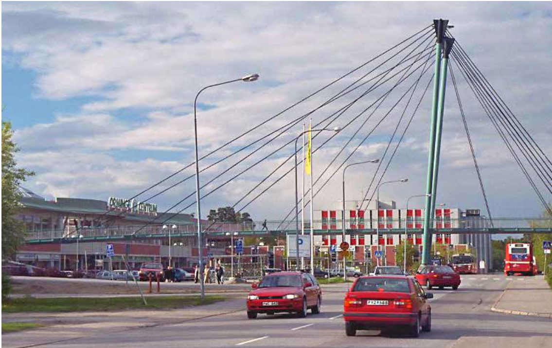
Orminge centrum, Kanholmsvägen. Centrumhuset till vänster i bilden och Ormingebuss bakom snedkabelbron.
