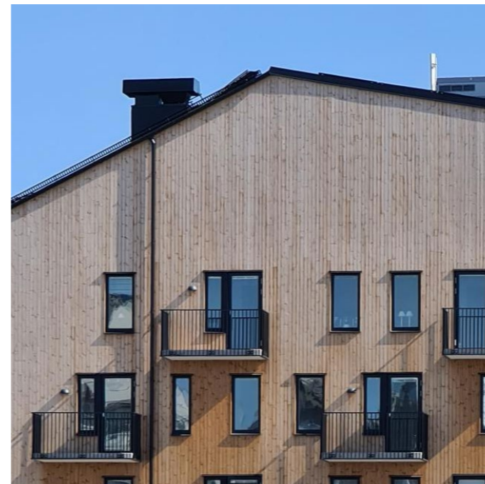
Thermowood efter ett år. Kv. Hydran, bostäder, Sverige
