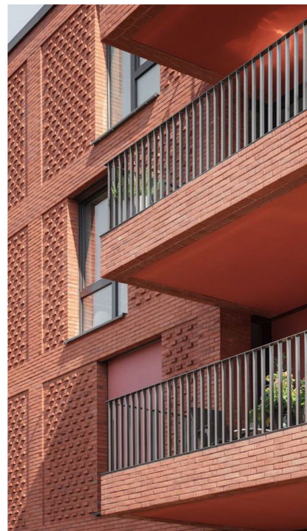
Agnes-Hundoegger-weg, Tyskland Balkonger har målade undersidor.
