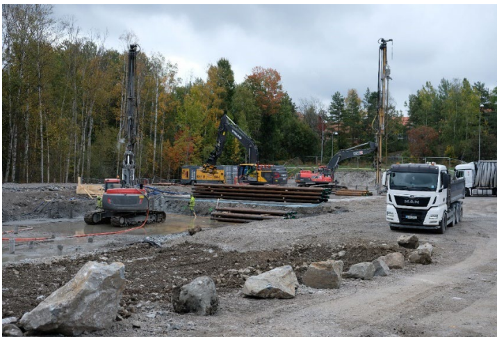
Bilden visar pågående förstärkningsåtgärder i samband med utbyggnad av gatumark strax söder om planområdet. I detta fall ett påldäck. Fotograf: T. Karlqvist 2021
