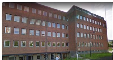
Befintlig fasad - Huvud kontor fasad mot Järnvägsgatan
