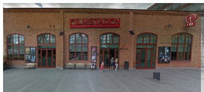
Befintlig fasad - Dieselverkstaden fasad mot Luftverkstad byggnad
