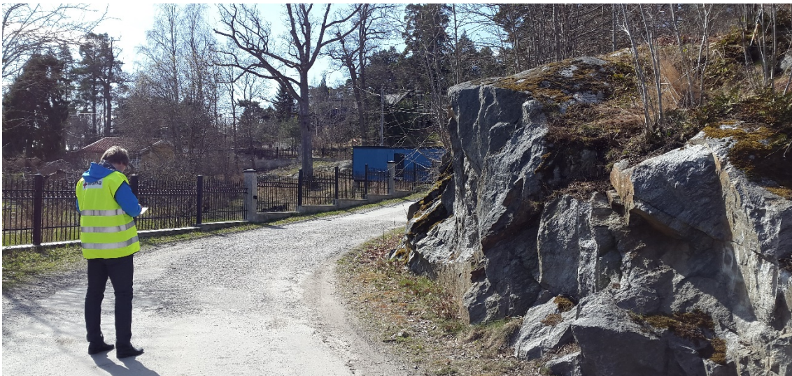
Figur 16. Korsning Boo strandväg/Fiskebovägen, platsbesök 160421
