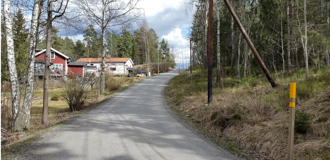
Figur 7. Ca 100 m från Evedalsvägens västra ände, platsbesök 160421
