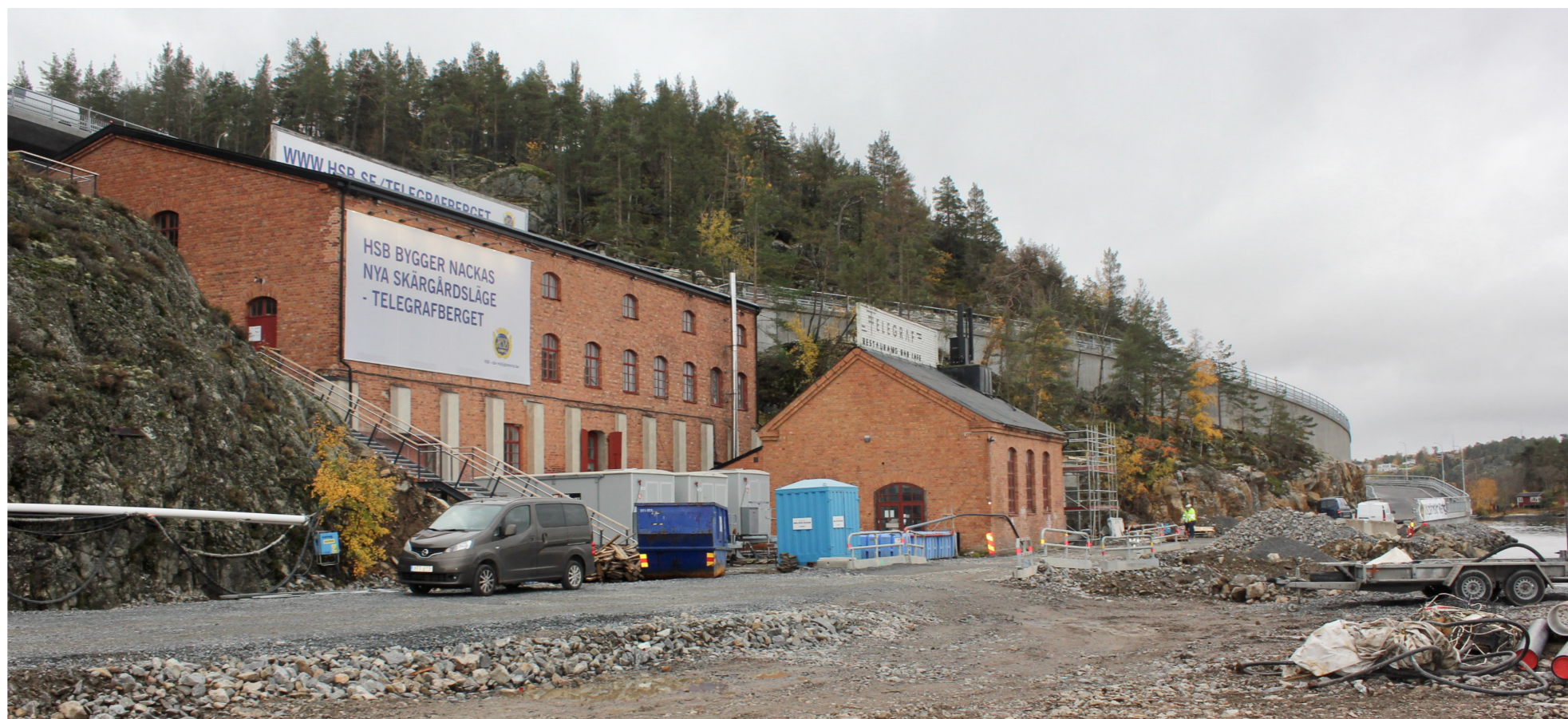
Intill den mindre tegelbyggnaden byggs en ny avloppspumpstation.
