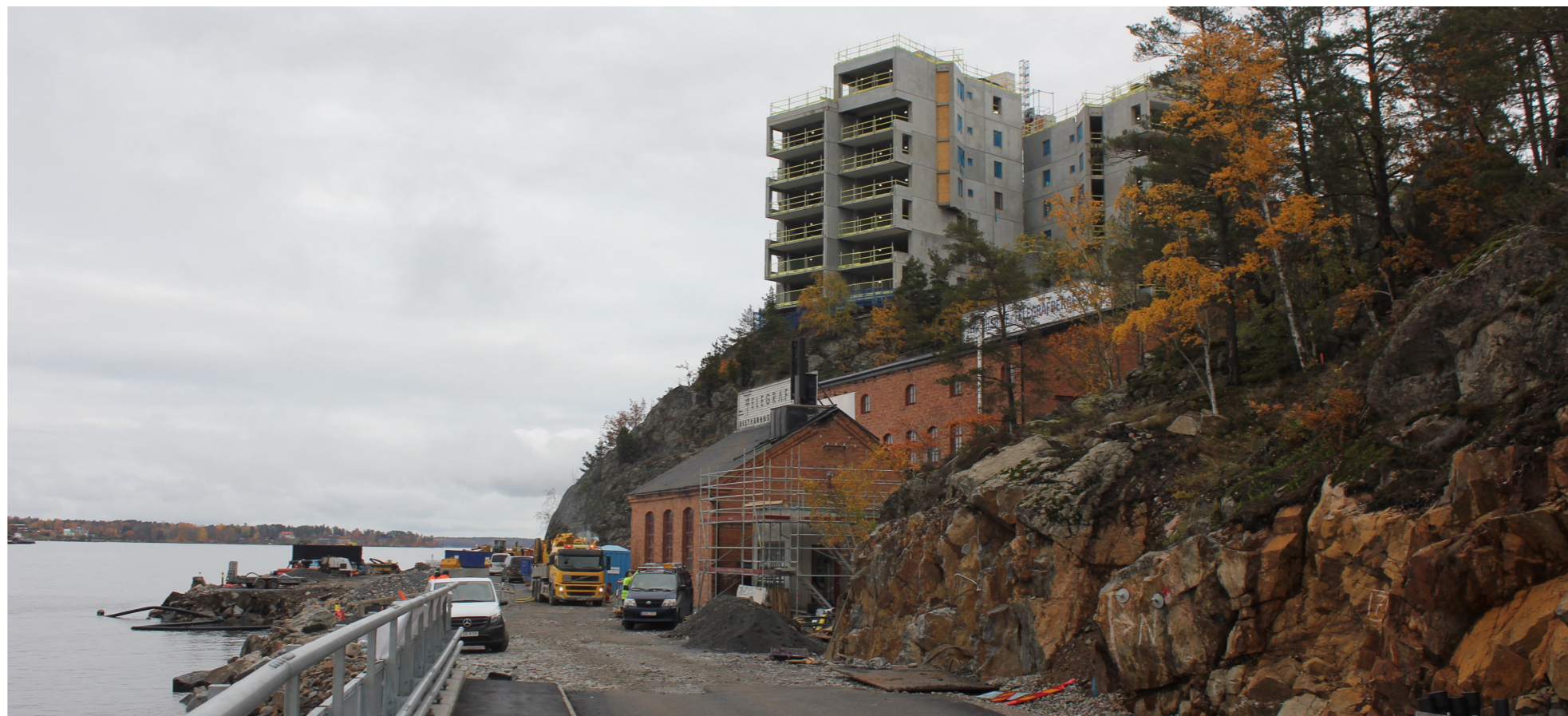
Anläggningen som den ser ut idag och det pågående bygget av nya flerbostadshus uppe på den plattå där det tidigare stod tre oljecisterner.
