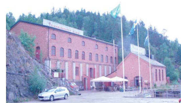
Befintliga tegelhus på kajen
