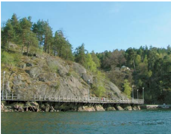
Strandpromenad på konsoler
