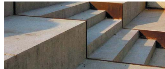
Platsgjuten betongtrappa med kantstöd av corténplåt
