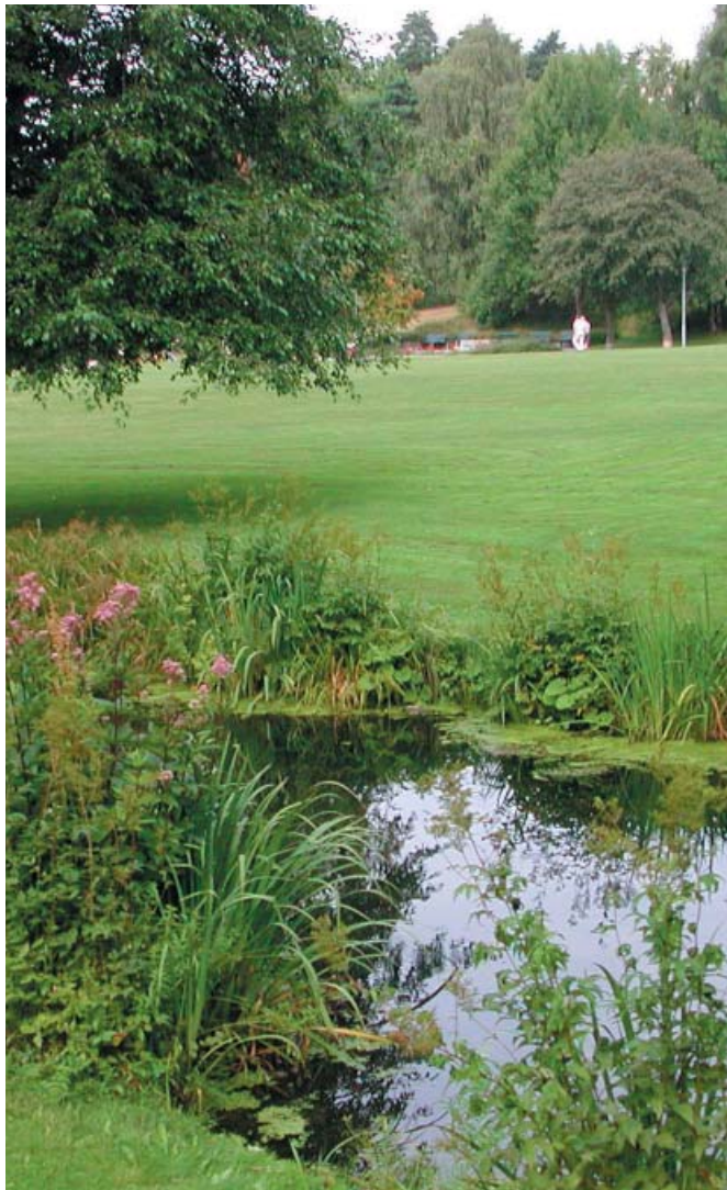
Exempel på omsorgsfull dagvattenhantering där material, strandskoning och växtlighet valts för att bli ett positivt tillskott i den kringliggande miljön. Vid stor nederbörd och höga flöden vattenfylls större diken och fungerar som fördröjningsmagasin.
