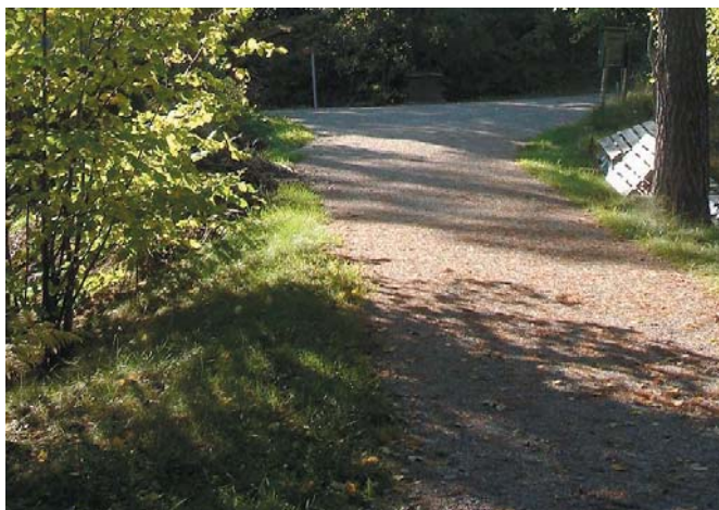
Mindre trafikerade vägar och gångstråk utförs med fördel med av hårt packat grus
