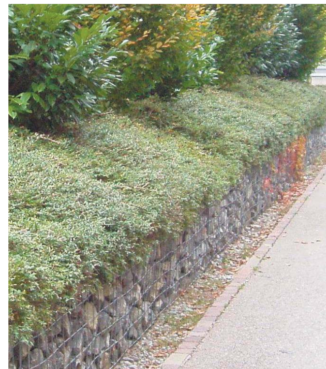
Överväxt gabionstenmur som kan passa för att ta upp mindre höjdskillnader
