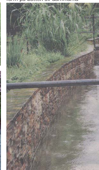
Tegel från bruket kan användas som stödmur mot vattenytan eller i korsad form på botten av dammarna
