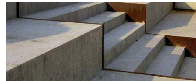
Platsgjuten betongtrappa med kantstöd av corténplåt
