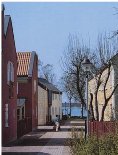
Intimt gaturum med utblick mot vattnet. Vadstena, (Asmussen Arkitekter)
