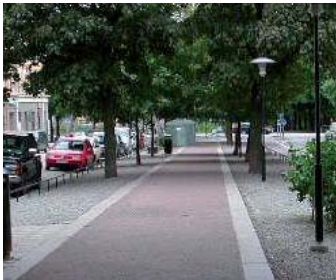
Ljus asfaltyta med kantsten av granit Katarina Bangata Stockholm
