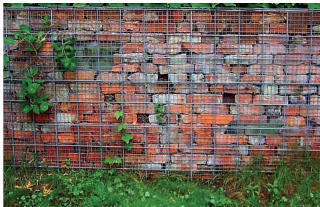
Gabion som tegelmur
