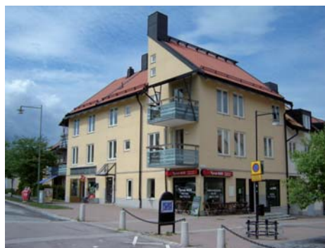
Service i bostadshusens bottenvåning ger liv åt stadsrummet, Tyreso Strandtorg. (Arken Arkitekter)
