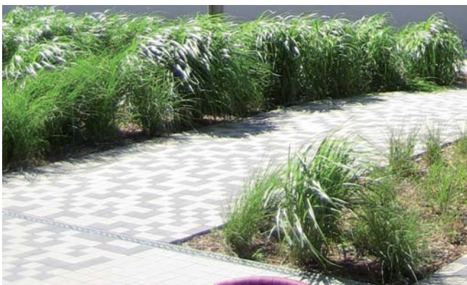
Markbeläggning av betongsten med plantering av högt gräs
