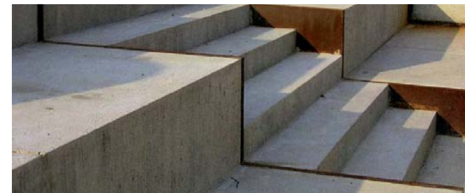
Platsgjuten betongtrappa med kantstöd av corténplåt
