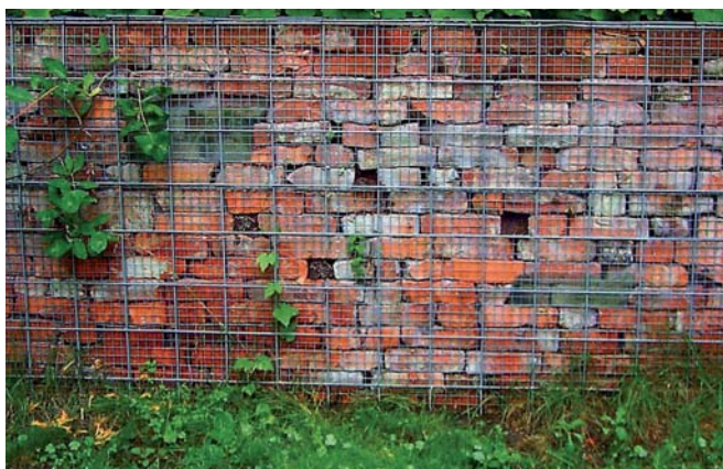
Gabion som tegelmur
