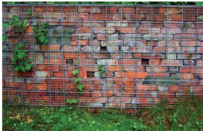
Gabion som tegelmur
