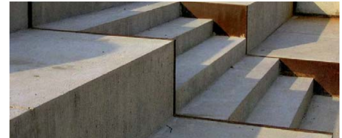
Platsgjuten betongtrappa med kantstöd av corténplåt
