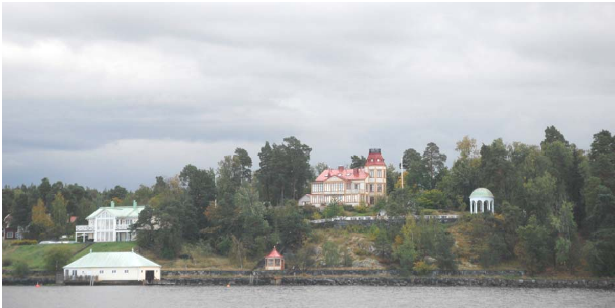
Karlshills tomtbild sedd från farleden. Till vänster båthus nedanför nybyggd villa. Båthuset, som ligger på Almdalens mark, har en karaktär från 1900-talets första årtionden. Det lilla strandnära lusthuset finns inte på ett foto från 1980-talet i Pihl Atmers bok Sommarnöjet i skärgården (sid 189). Foto 2009
