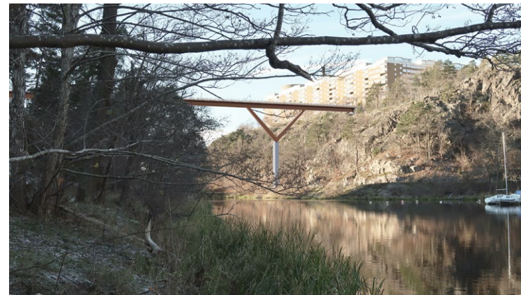
Figur 49. Konceptuell illustration. Möjlig utformning av det östra broalternativet sett från Svindersvikens södra strand (Bildkälla: Knight Architects).
