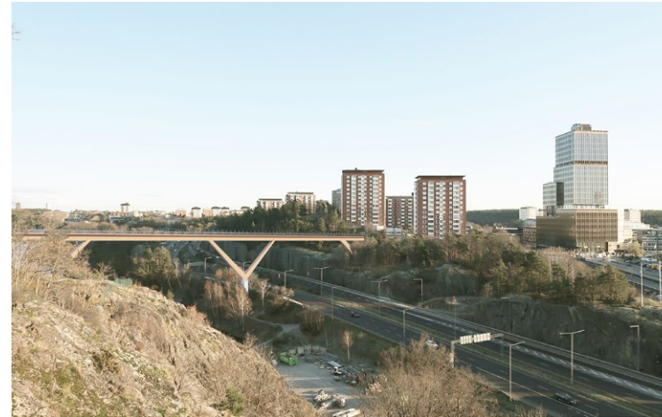
Figur 48. Konceptuell illustration. Vy mot öster som visar möjlig sträckning och utformning av det östra broalternativet sett från Henriksdalsberget (Bildkälla: Knight Architects).
