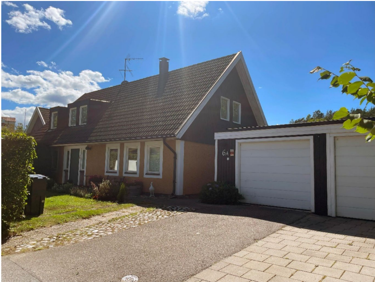
Figur 6. Bostadshuset med tillhörande dubbelgarage på Rösunda 38:16, sett från Amiralsvägen. (Nacka kommun, 2024)
