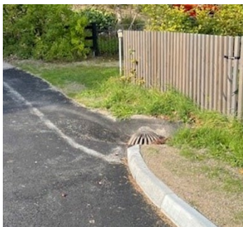
Figur 13. Kupolbrunnen i fastighetsgränsen mellan Rösunda 38:18 och Rösunda 38:17. Vid ett beläggningsarbete hösten 2024 anordnades så att vattnet från gatan leds ner i brunnen. Den tidigare kantstenen/upphöjningen av asfalt kommer att återställas. (Privat foto från en av fastighetsägarna i området, sep 2024)
