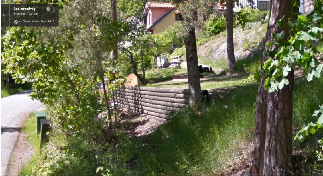
Bild 9 Stödmur av trä som rivs
