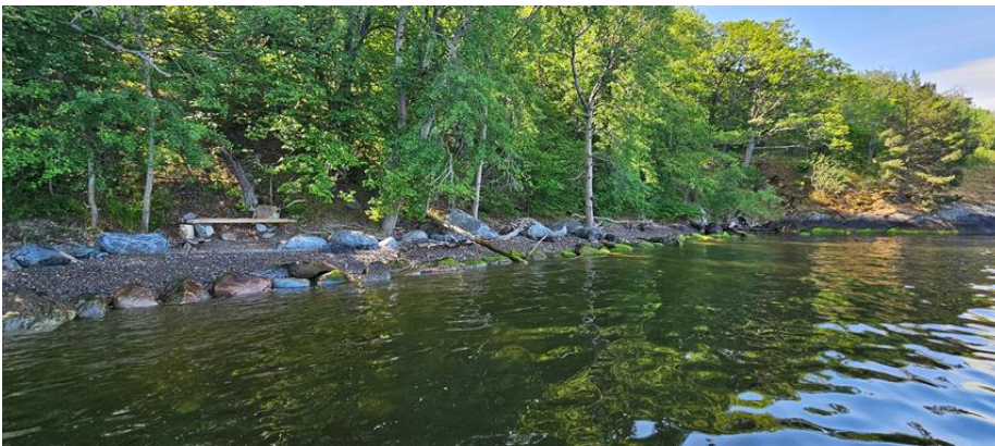
Figur 8. Block har lagts upp längs stranden som skydd mot erosion.
