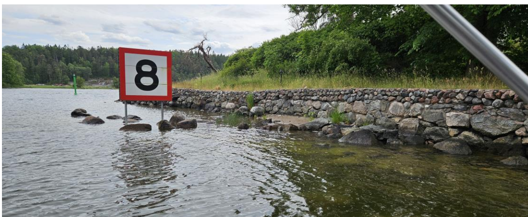
Figur 23. Stensatt kaj vid udden, delvis utrasad.
