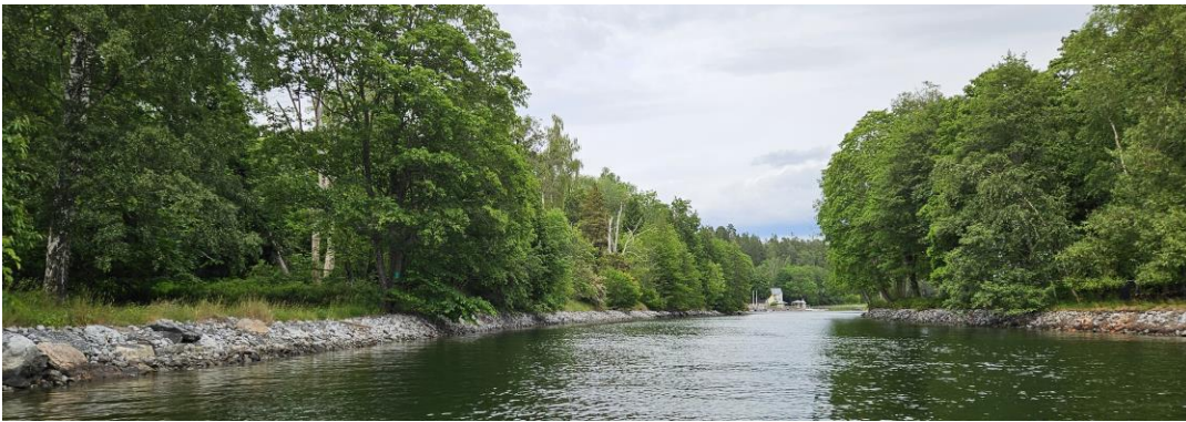
Figur 24. Utfyllda, sten- och blockförstärkta strandkanter i Stäket.
