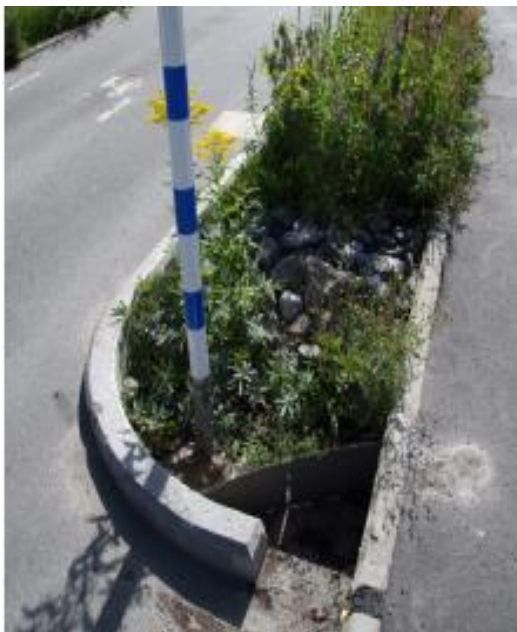
Figur 23. Exempel på hur ett avbrott i kantstenen kring en växtbädd kan användas för att skapa ett inlopp för dagvattnet. I bilden syns även en sedimentationshåla vid inloppet. Bild av WRS hämtad från Stockholm Vatten och Avfall (SVOA).
