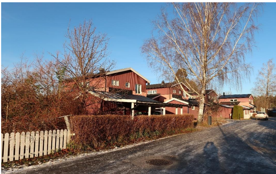
Figur 11: Vy från Tallkottsvägen. De ursprungliga komplementbyggnaderna som placerats närmast gatan samspelar med huvudbyggnaderna i sin gestaltning. Foto: Nacka kommun.
