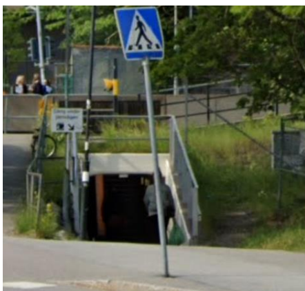
Gångtunnel under Saltsjöbanan och Värmdövägen.
